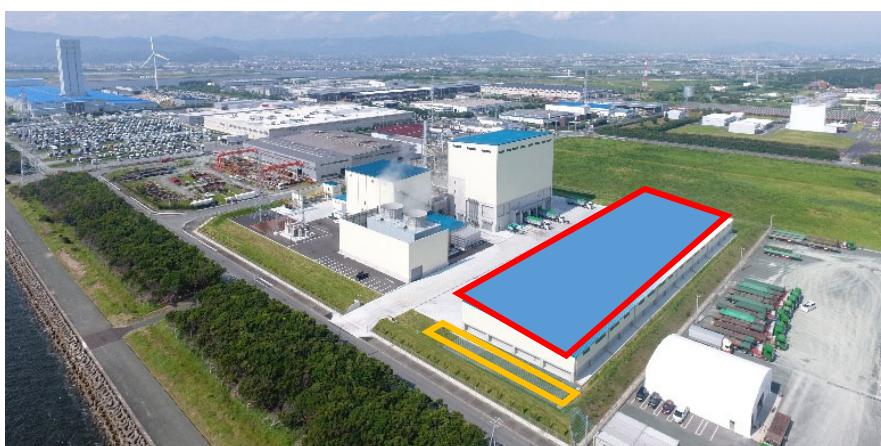
■ 太陽光パネル設置予定エリア ■ 蓄電池・受電盤等設置予定エリア
