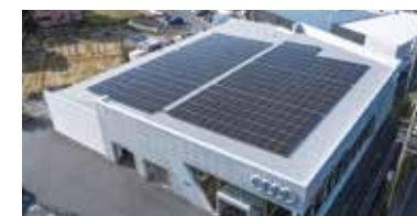
太陽光設備の設置
